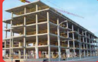
Estructura de Hormigon
