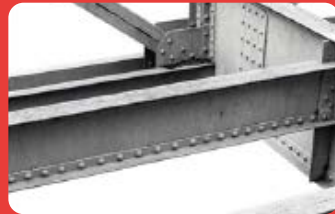
Vigas y Columnas
